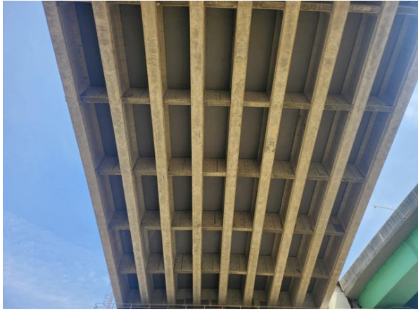
바닥판 하면 및 거더 전경
