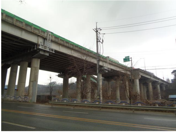
교량 측면 전경
